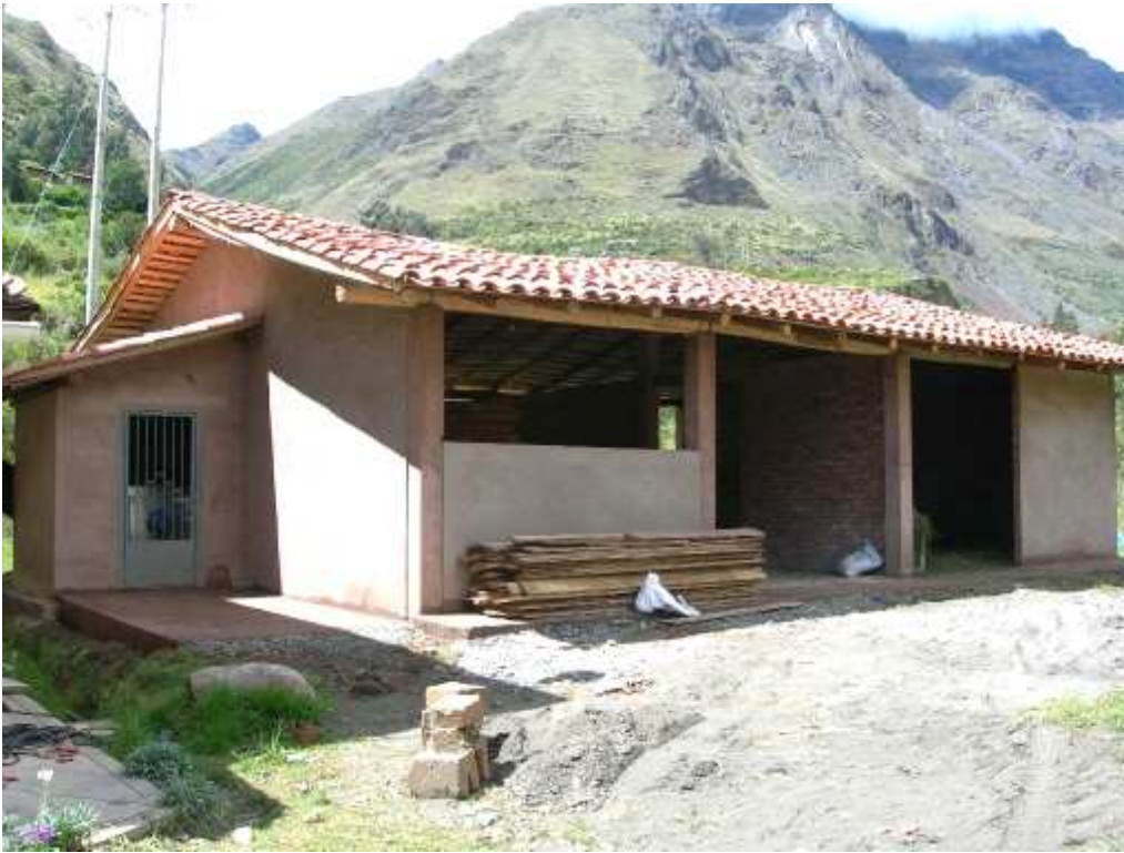
Fig. 12 - Vista di fronte dell'essiccatoio finito. A sinistra l'alloggiamento del gruppo termoventilante, attraverso grata della porta è visibile il ventilatore
