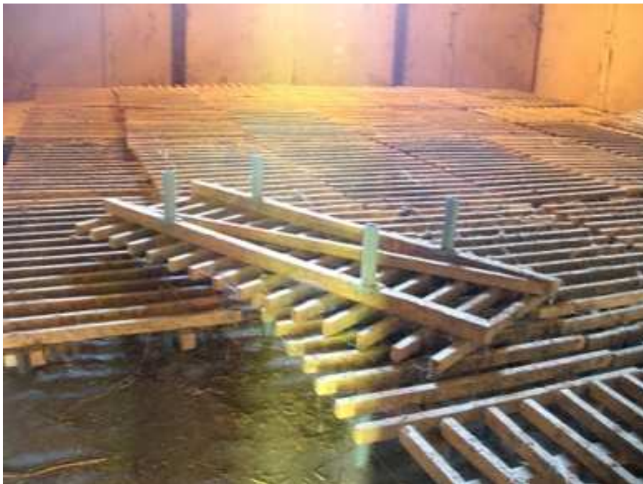
Fig. 9 - Una platea con il graticciato rimosso e rovesciato per evidenziarne la costruzione
