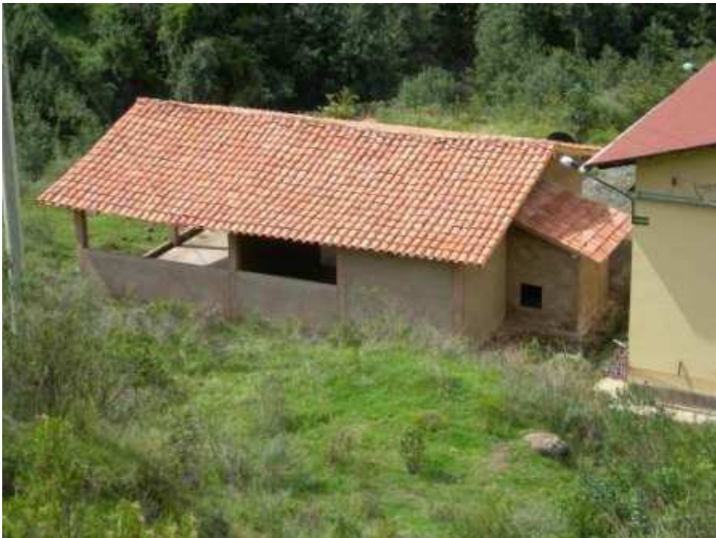
Fig. 13 - vista posteriore dell'edificio
