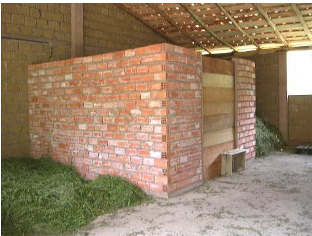
Fig. 14 - L'interno con la cella di essiccazione
